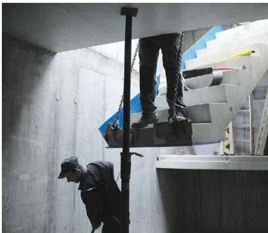
In der Luft: Fertigtreppe aus Beton beim Projekt „Luftschloss“ Fotos: 3HäuserProjekt
